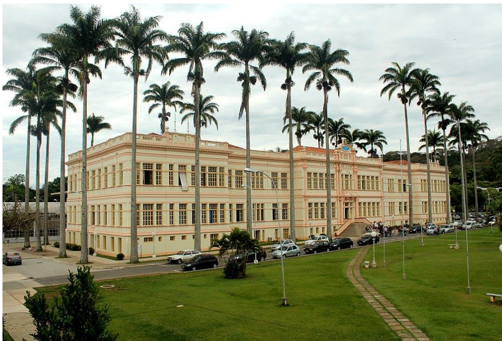
Figura 1: Edifício Arthur Bernardes, sede do Núcleo de Inovação Tecnológica da UFV.
